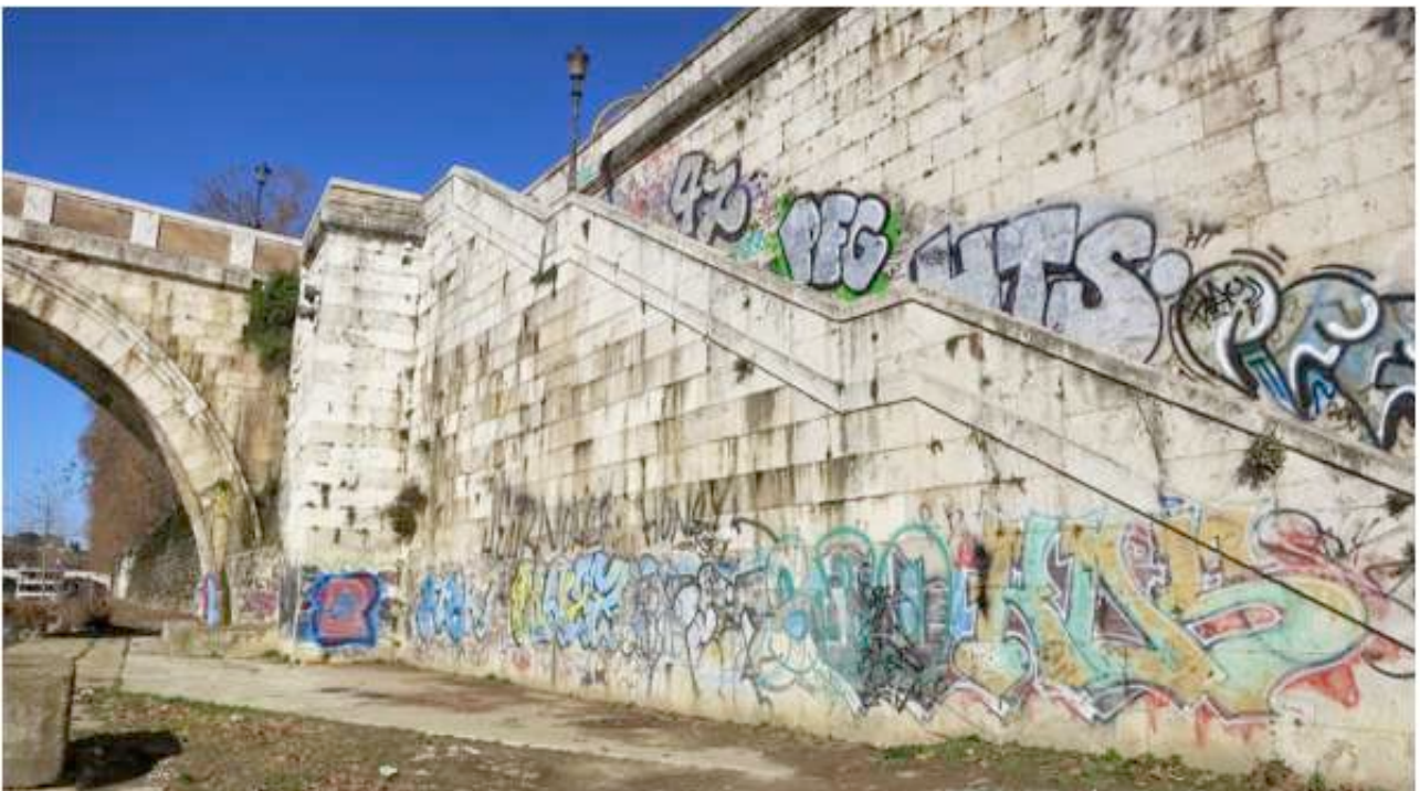
Banchine Lungotevere dei Vallati
