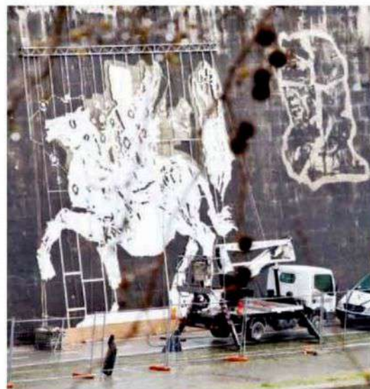
Le proporzioni. Veduta d'insieme del cantiere sul Tevere. FOTO: LEONARDO PUCCINI
